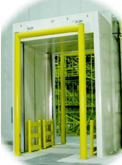
Installed HCR Air Door
