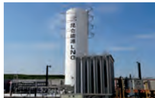
Farm LNG Heating System
